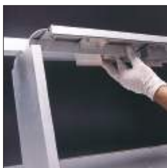
FISSAGGIO TUBO QUADRI 30X30 PER STAFFA
